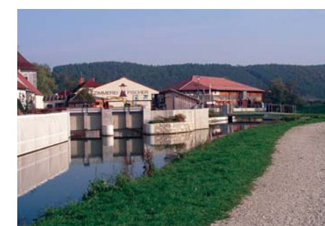
BA 03 Hochwasser- verschlüsse, Klappenwehr
