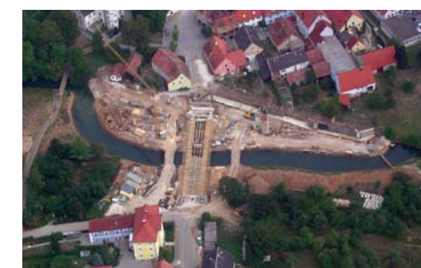
BA 01 Spannbeton- und Doppel- bogenbrücke, Ufermauern
