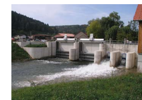
BA 04 Hochwasser- verschluss in der "Alten Vils" und Schöpfwerk
