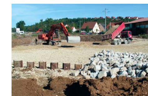
BA 02 Flutmulde, Sohlgleite, Filter
